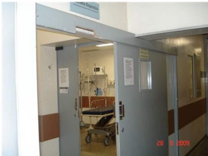
FIGURA 37 – SALA DE ISOLAMENTO RESPIRATÓRIO COM PRESSÃO NEGATIVA NA SALA DE URGÊNCIA DA U.E.
