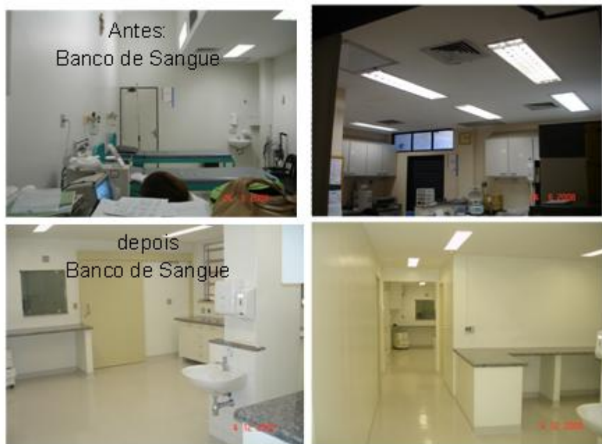
FIGURA 19 – REALOCAÇÃO E REFORMA DO BANCO DE SANGUE.
