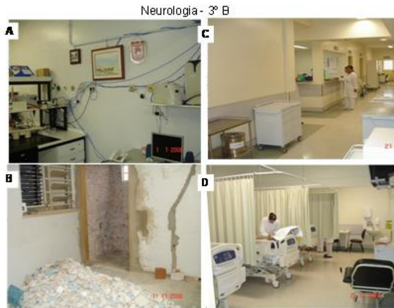
FIGURA 16 – READEQUAÇÃO DO 3º ANDAR BLOCO B – INSTALAÇÃO DA NEUROLOGIA (A;B = ANTES; C;D = DEPOIS)
