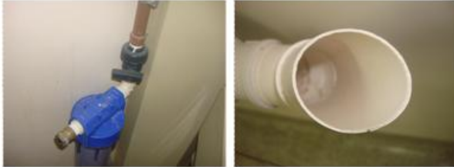
FIGURA 53 – VISTORIA DA VISA – SISTEMA DE ESCOAMENTO DE DIÁLISE INADEQUADO
